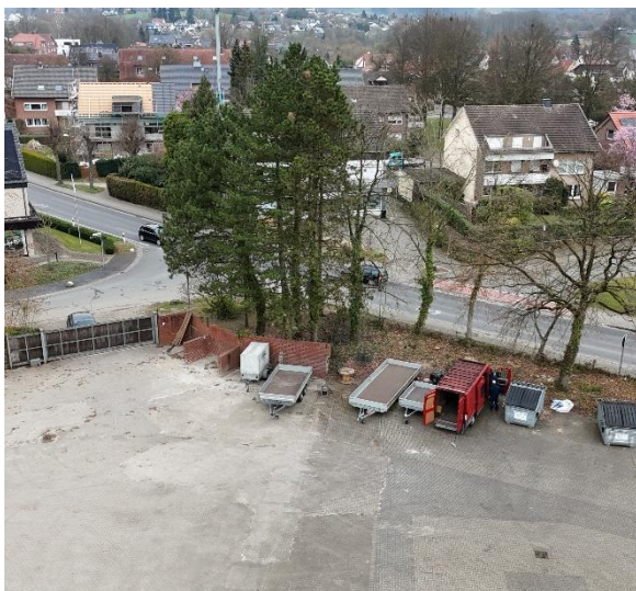
Abb. 2-1 Versiegelte Betriebsfläche mit Gehölzbestand
