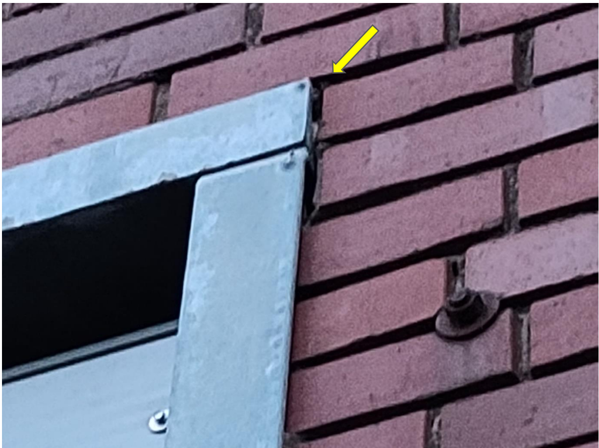
Abb.12: Detailansicht der Einflugstelle (gelber Pfeil)
