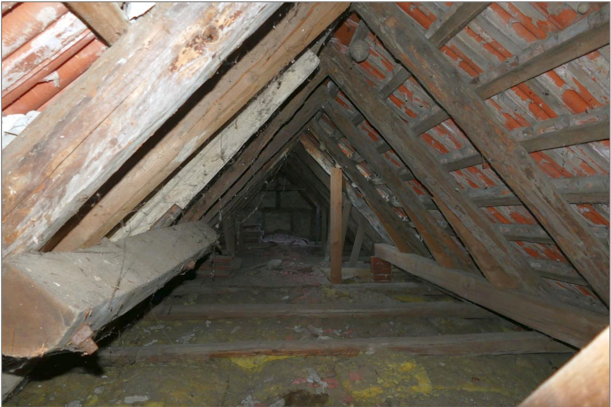
Abb.7: Niedriger Dachstuhl ohne Dämmung, in diesem Bereich nicht begehbar
