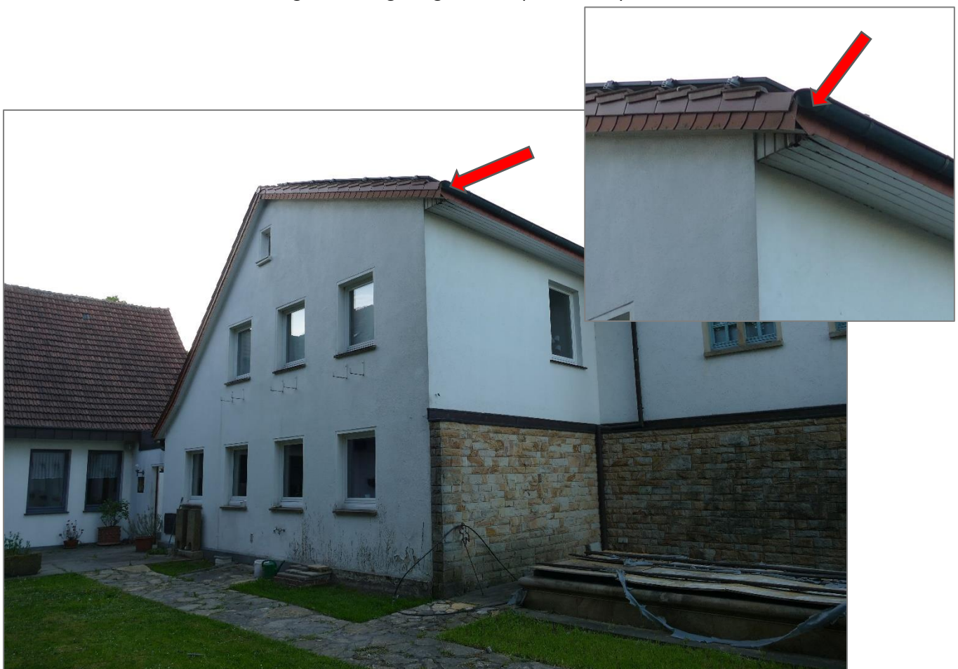
Abb.6: Öffnung in dem Traufkasten, Quartiermöglichkeit (rote Pfeile)
