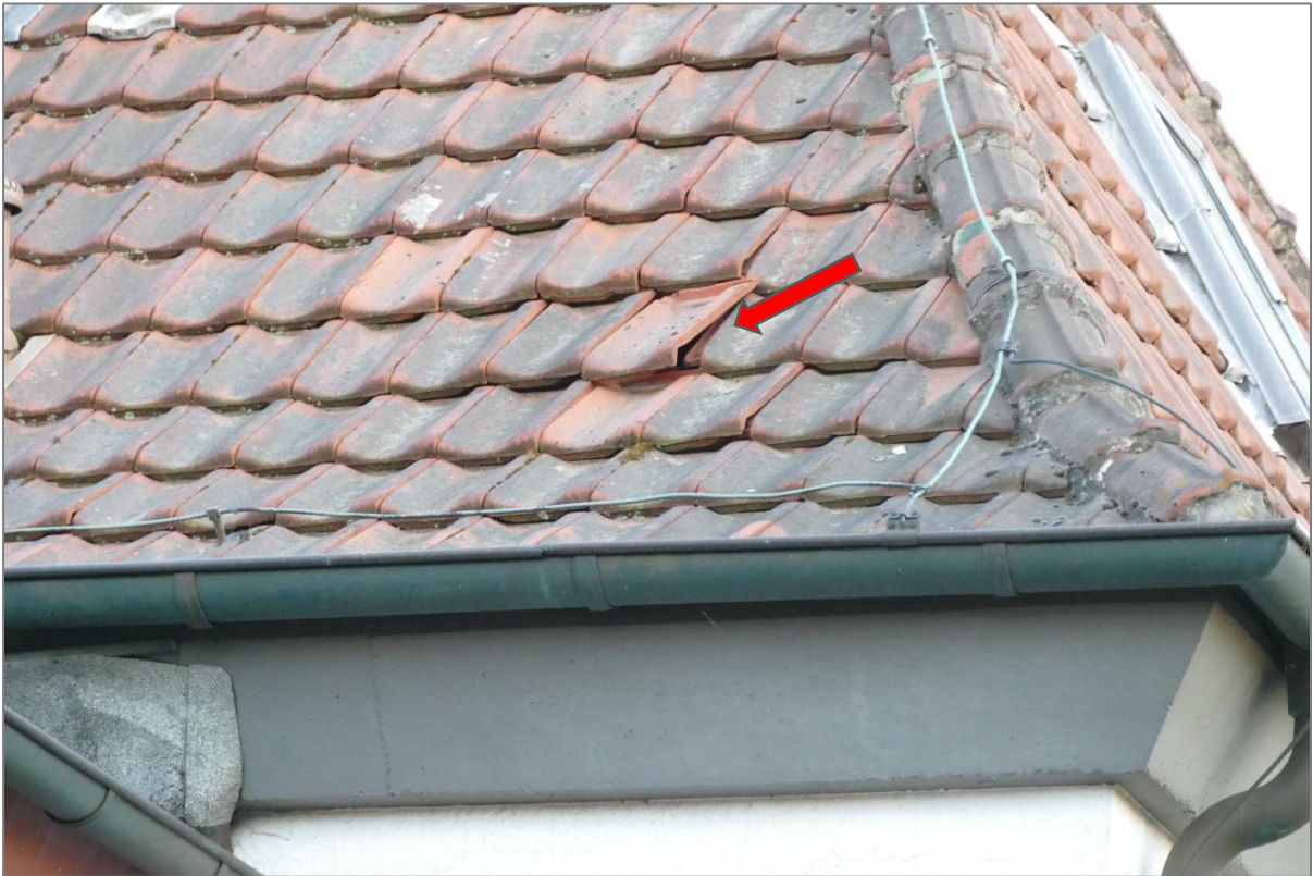
Abb.5: Abstehernder Dachziegel, Einflugmöglichkeit (roter Pfeil)
