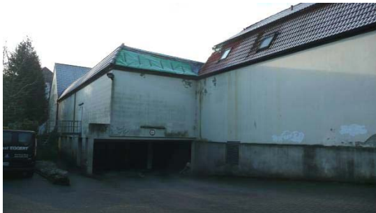
Ansicht vom Parkplatz, Zufahrt Tiefgarage
