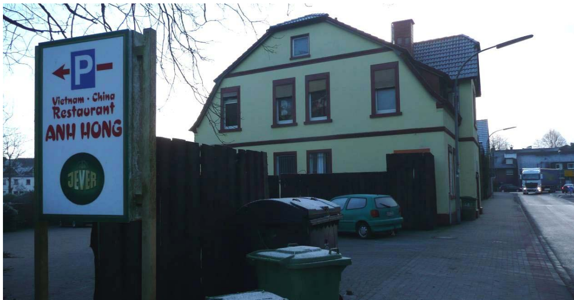
Charlottenburger Ring 41, ehemaliges Wohnhaus, derzeit Übergangsnutzung Bordell
