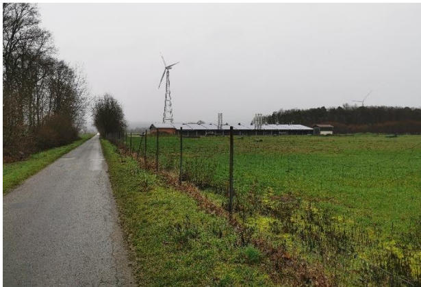
Blick auf das Plangebiet aus Richtung Süden
