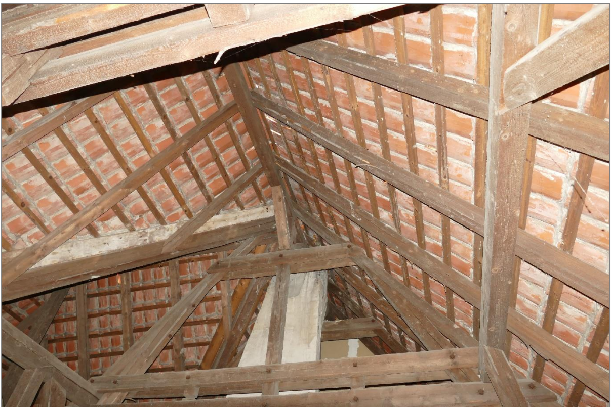
Abb.2: geräumiger Dachboden, Verstecke in Balkenkonstruktion potentiell auch für das Braune Langohr geeignet
